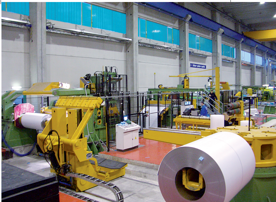
Vista dello slitter dal lato di avvolgimento dei nastri; in primo piano in basso, la giostra a quattro bracci per lo scarico delle bandelle dalla culla di scarico.
